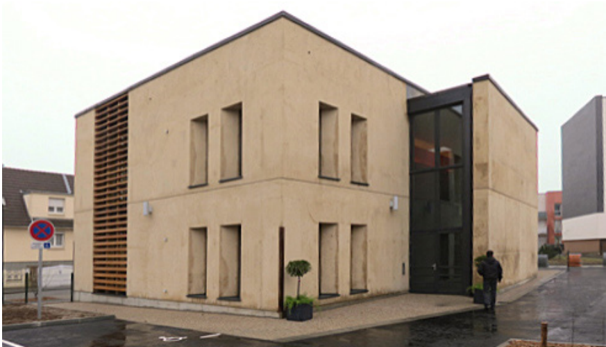
Figure 36 - Local tertiaire en Cématerre
